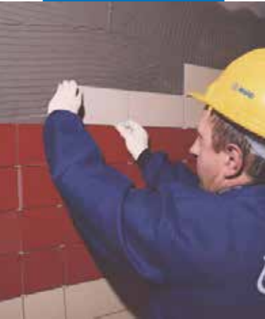
Полагане на керамични плочки на стена отгоре надолу
